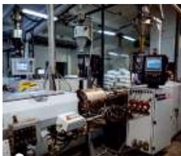
Цех по производству канализации
